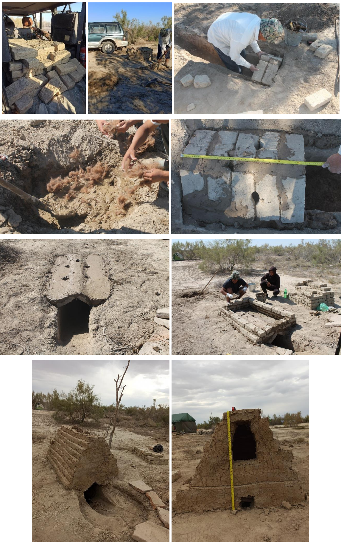
Рисунок 101. Поэтапное строительство горна
