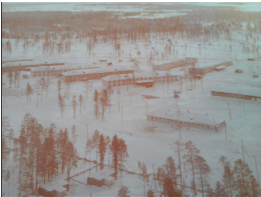
Фото 26. Вахтовый посёлок. 1980-е гг. (М.И.Т.ГМУ Ф. Архив фотоматериалов)
